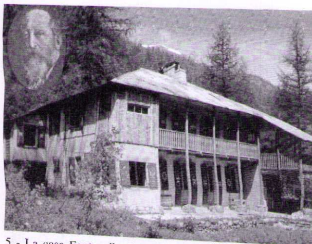
5 - La casa Fontanalba, la maison de Clarence, construite à Casterino entre 1904 et 1905.
